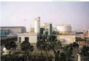
Veduta di insieme della piattaforma impiantistica
