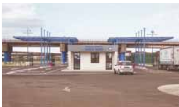
Nuovo varco di accesso al Porto di Taranto
